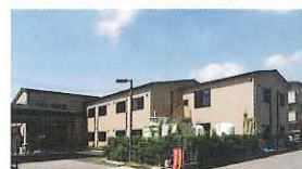
NSハイパーフレーム工法で建設された老人介護施設
