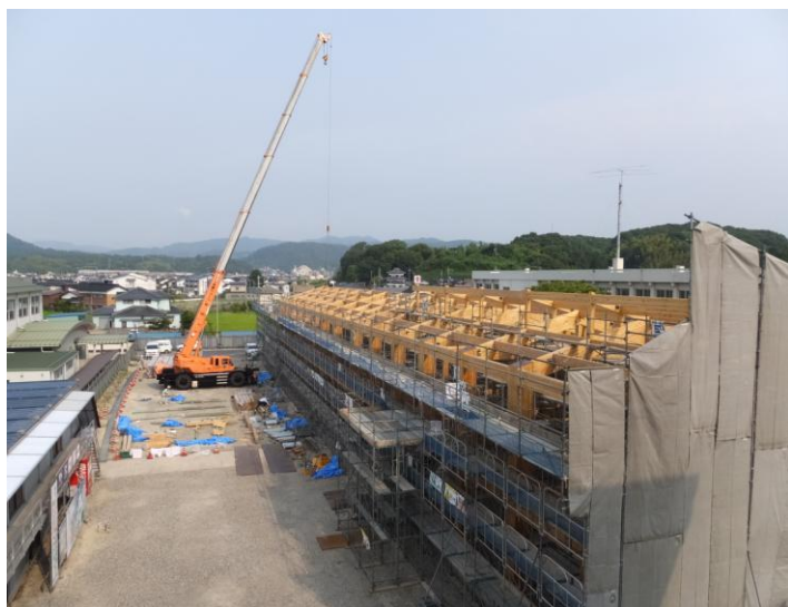
類似物件建て方状況
